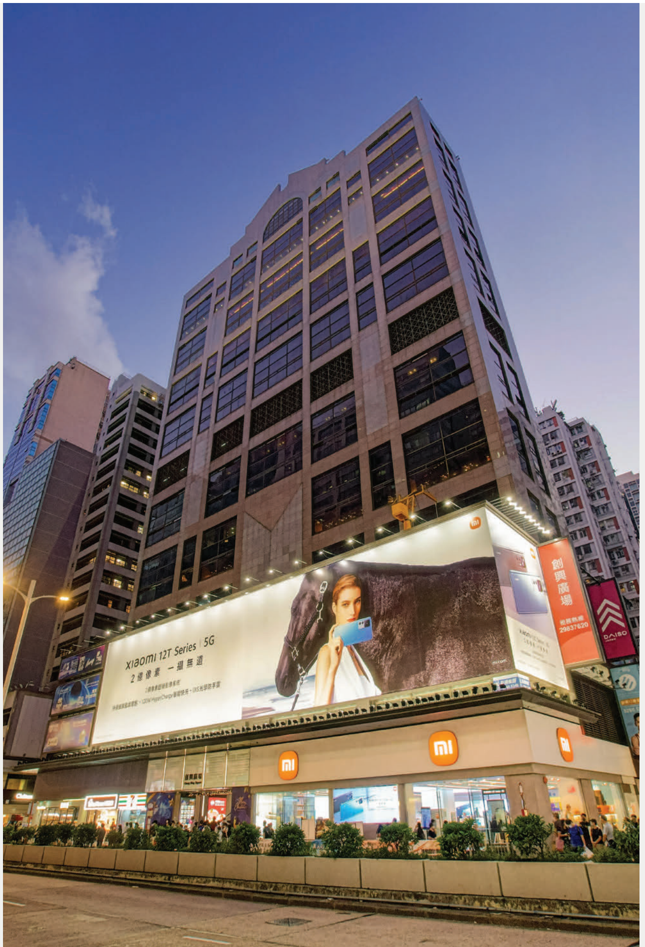
Chong Hing Square 創興廣場
