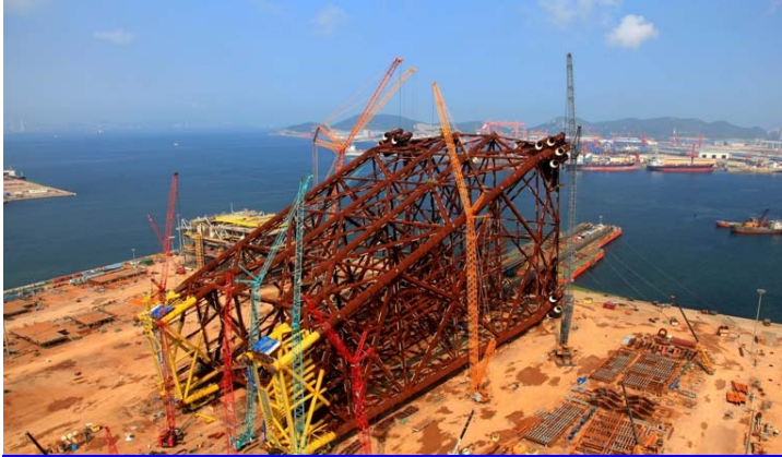
3万吨级大型导管架陆地建造
