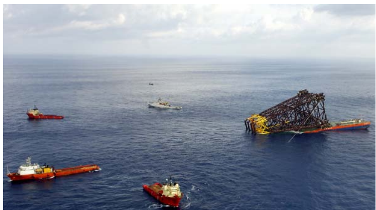
番禺5-1项目导管架滑移下水海上安装
