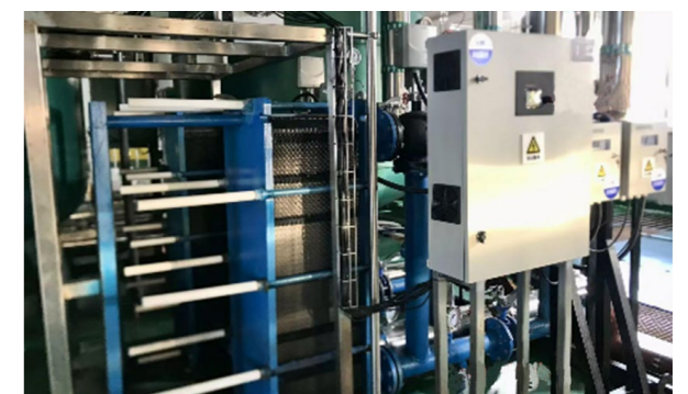
龍江工廠冷凝水回收改造項目
