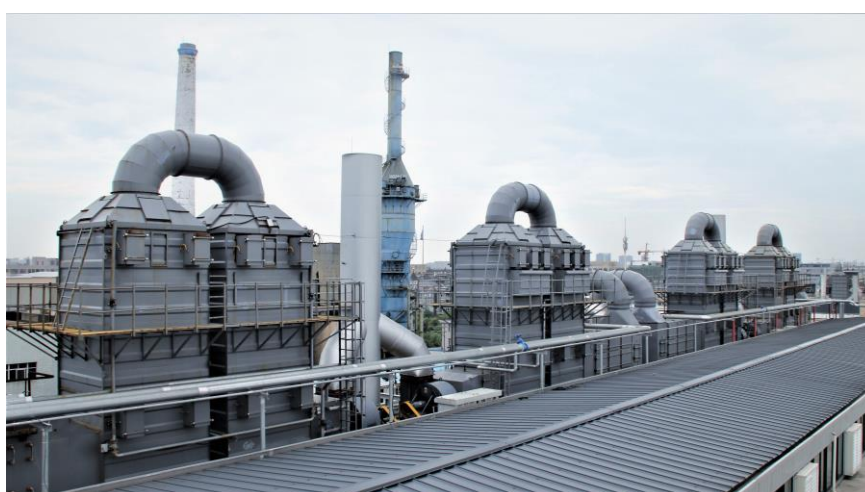
工业油烟净化设备安装实景图
