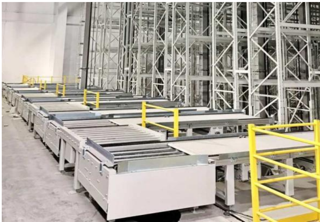
北自科技——上药控股江苏股份有限公司现代医药物流中心
