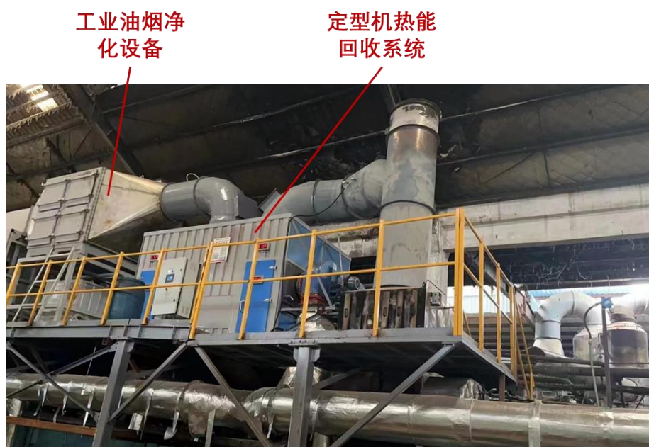
定型机热能回收系统设备安装实景图
