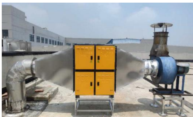
一般餐饮用户商用油烟净化设备安装实景图
