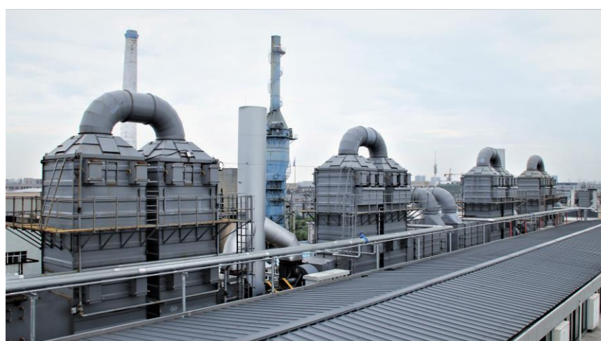
工业油烟净化设备安装实景图
