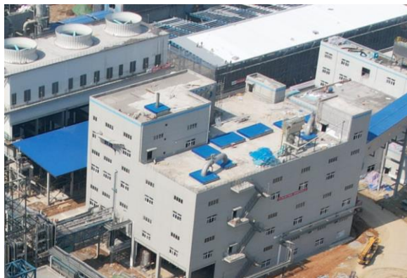
图 联碱节能技术升级改造项目建设现场
