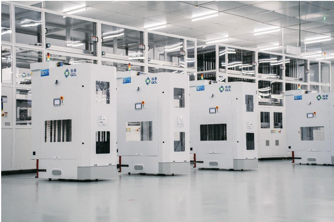
图片来源：芜湖电池基地生产线实拍图
