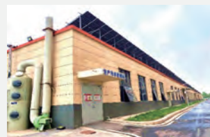
自建废水处理站
