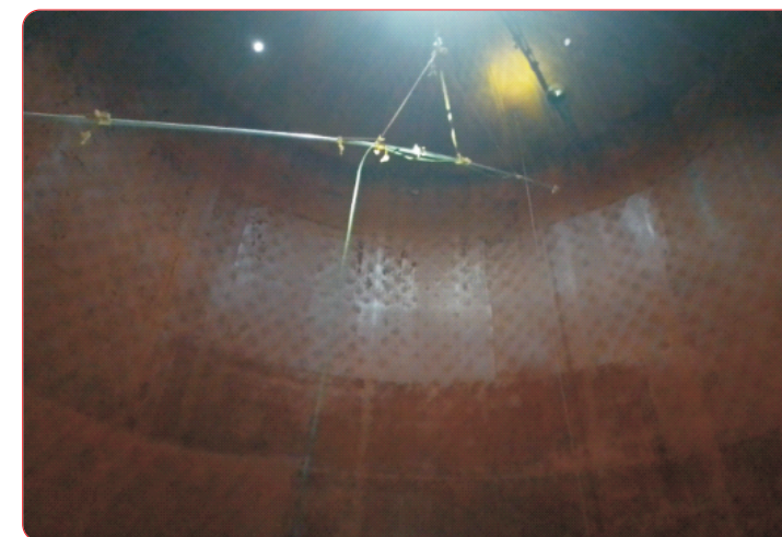
智能高压洗罐作业
