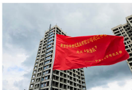
党员突击队旗帜在施工现场高高飘扬
