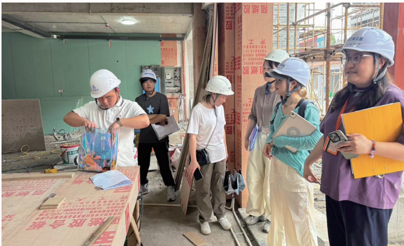
● 公司组建青年突击队，为衡阳青春东州岛项目建设提供了有力支撑。
