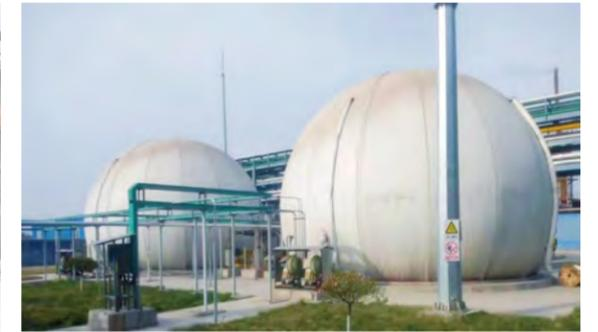
利用废水处理过程中产生的沼气作为热风炉燃料，降低了天然气的使用，有效推动资源循环利用，减轻了对环境的影响。
