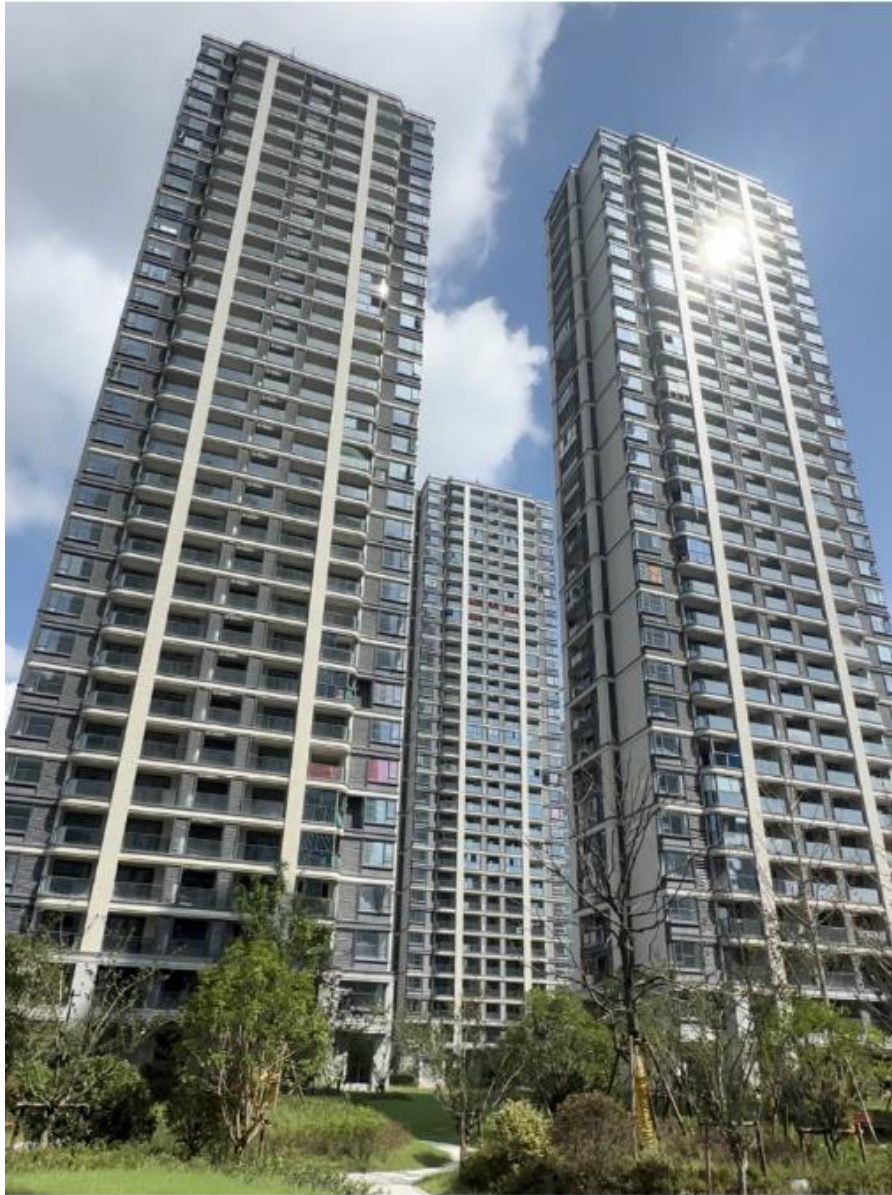
常青拆迁安置房项目实景图
