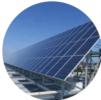
安装屋顶光伏
