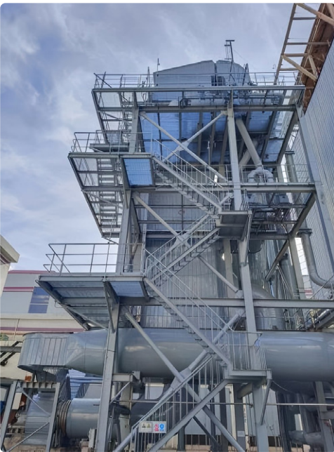
长材加热炉废气 SCR 脱硝设备
