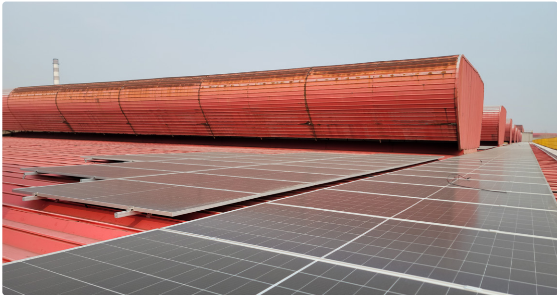
屋顶光伏发电板
