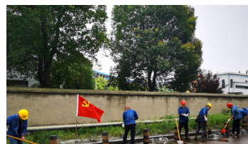
党员突击队疏通排水沟渠
