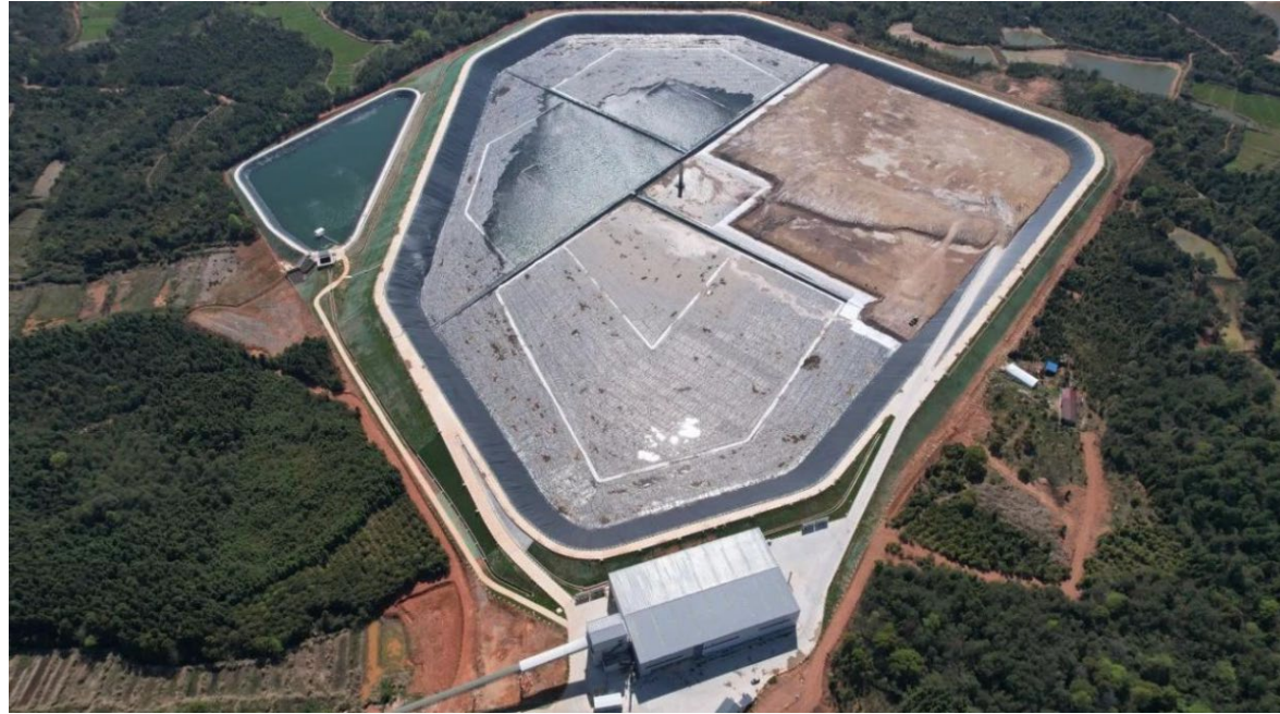
奉新时代浸出渣场
