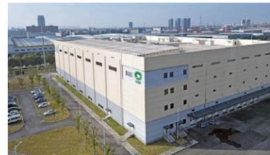
湖北物流中心位于湖北武汉，占地面积约60亩，一期仓库面积2.84万平方米，由托盘立体库和四层平库构成，最大存储量约33万件。物流中心引进了AGV货到人拣选，与DPS拣选结合形成并发式多任务拆零拣选系统，年出库能力490万箱。
