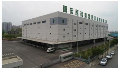
四川物流中心位于四川广汉，占地面积约90.7亩，一期仓库面积3.1万平方米，由托盘立体库和四层平库构成，最大存储量约33万箱。物流中心引进了AGV货到人拣选，与DPS拣选结合形成并发式多任务拆零拣选系统，年出库能力490万箱。
