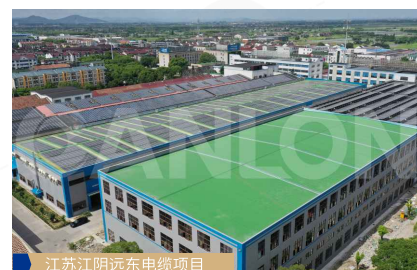
江苏江阴远东电缆项目
