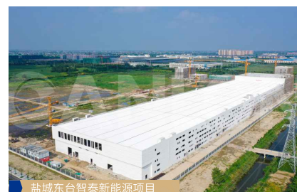
盐城东台智泰新能源项目
