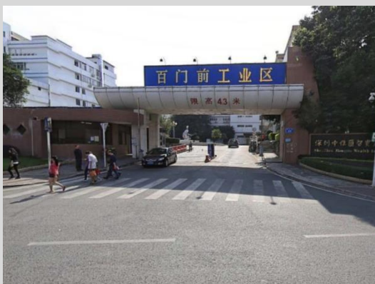
改造前入口实景
