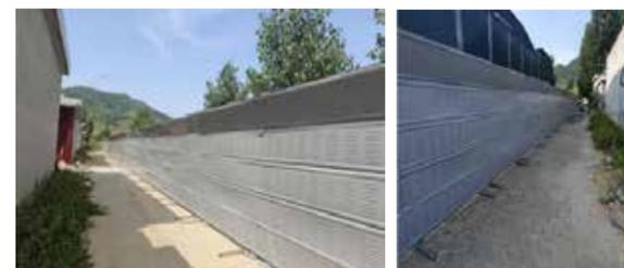
如在施工面接触居民生活区的一侧安装移动式声屏障，有效隔绝施工噪声的传播，降低了对居民生活的影响。声屏障的材质通常选用隔音效果好的材料，如吸音板、隔音墙等，其高度和长度根据施工现场的实际情况进行设计，确保能够最大程度地阻挡噪声。
