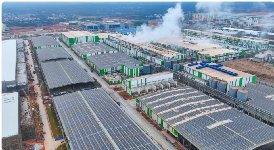
图为公司南宁园区光伏发电项目
