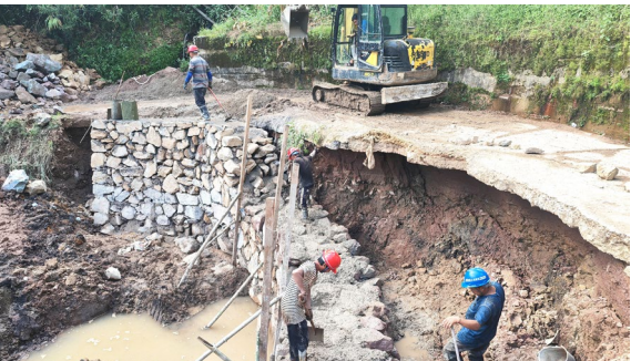
悬空路段建设情况
