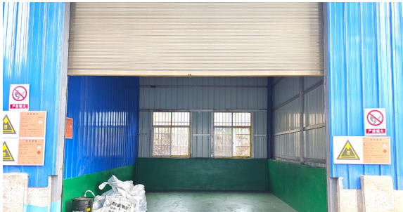
堆存危险废物的贮存库
