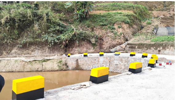
悬空路段建设情况
