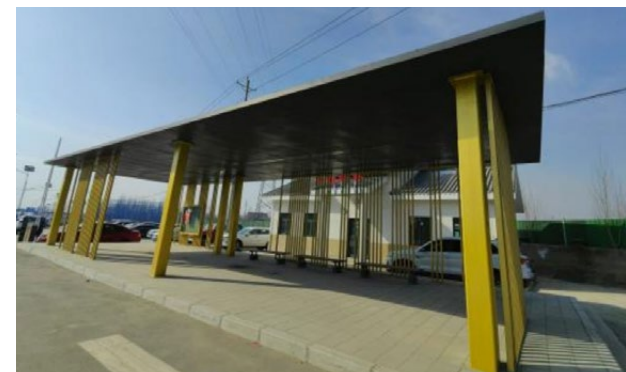
协助社区修缮停车场、环卫工人休息室、公交站台、老旧小区翻修改造
