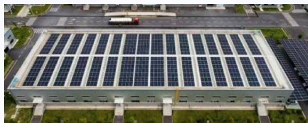
分布式光伏发电项目
