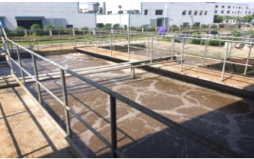
帘子布厂区污水处理站
