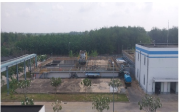
越南厂区污水处理站
