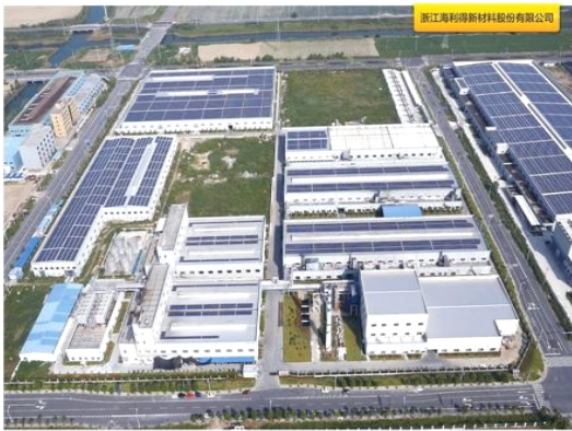
尖山厂区太阳能板
