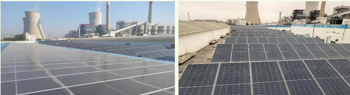
航天智造保定分太阳能光伏发电一期项目
