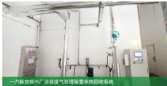
一汽解放柳州厂涂装废气处理装置余热回收系统
