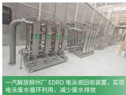
一汽解放柳州厂 EDRO 电泳液回收装置，实现电泳废水循环利用，减少废水排放
