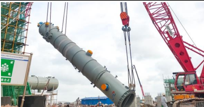
名称: 甲醇装置-中间换热器 规格: DN2300*(78+4)*21001 F=4816m 2 材料: 14Cr1MoR+S30408/14Cr1MoIV/S30408 重量: 190T
