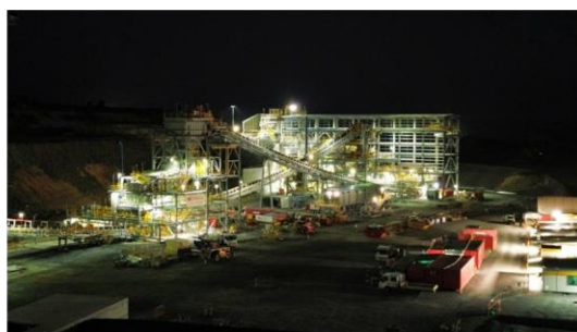
化学级锂精矿工厂三期干法区建设进展
