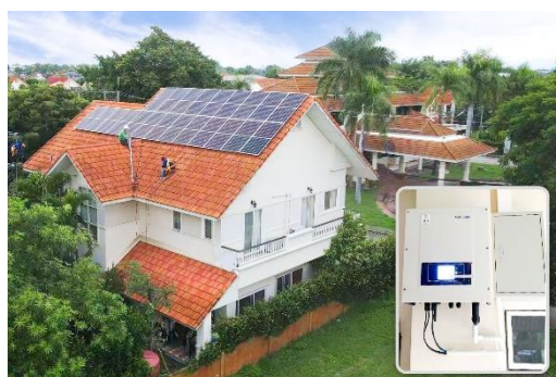
泰国 11kW 项目
