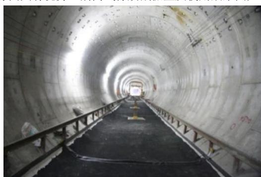
隔离式橡胶减振垫使用效果图
