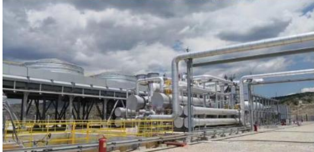
Transmark 项目全景图
