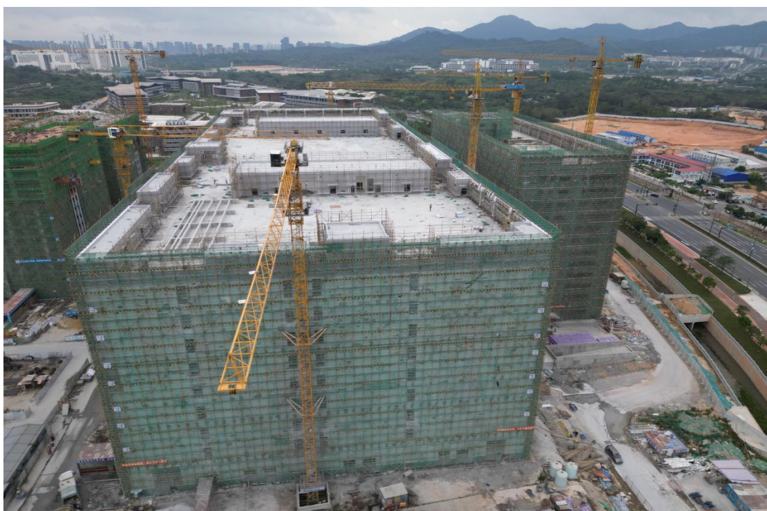
本次募投项目生产厂房（图中居中建筑物）建设现状（侧面）
