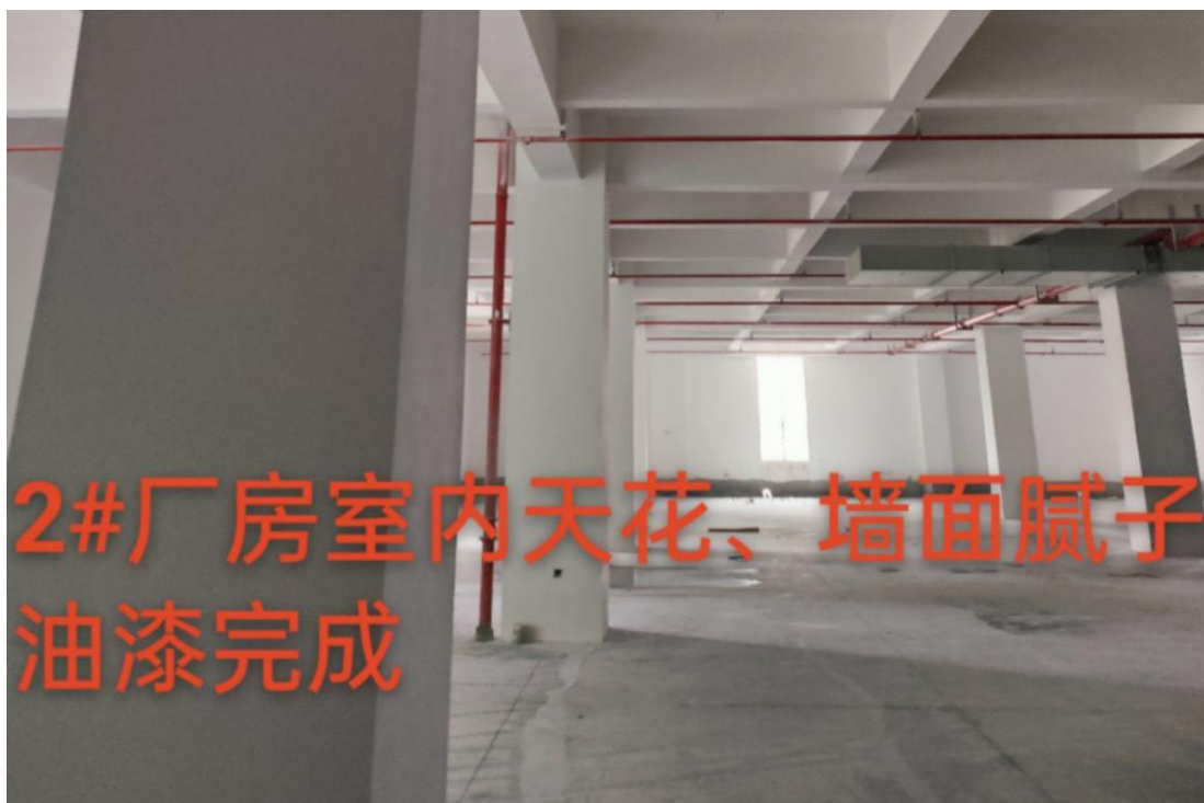
本次募投项目生产厂房内部建设现状
