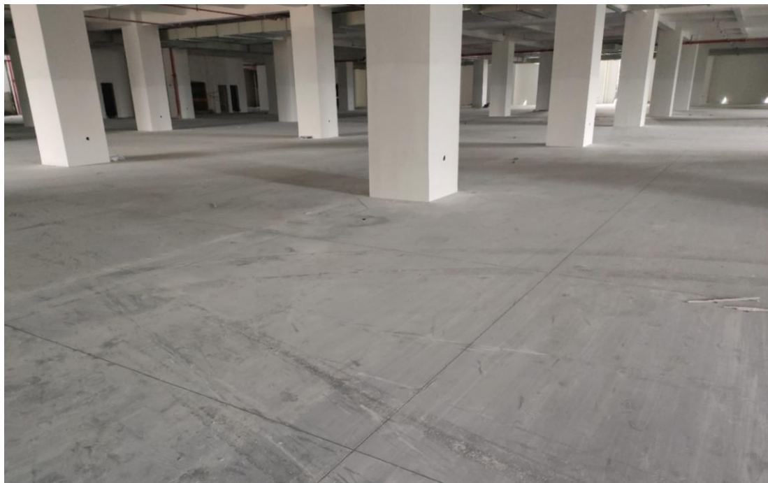
本次募投项目生产厂房内部建设现状
