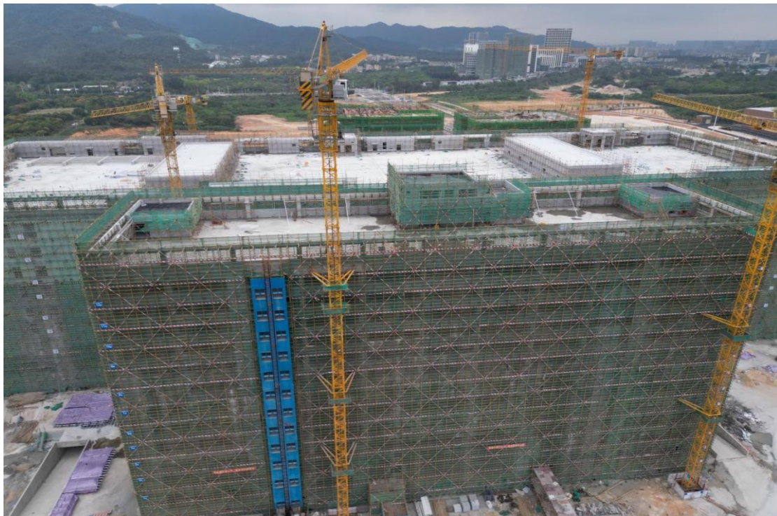
本次募投项目生产厂房（图中后侧建筑物）建设现状（正面）
