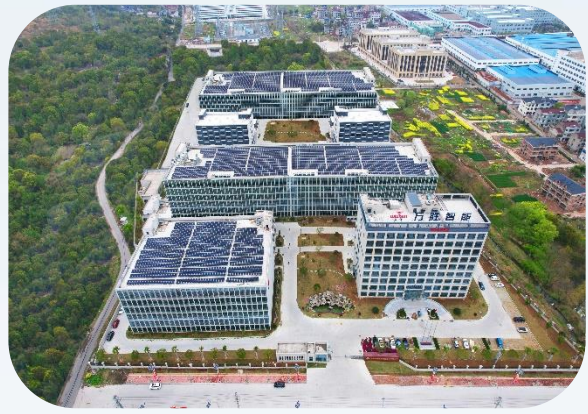
生产基地屋顶光伏
