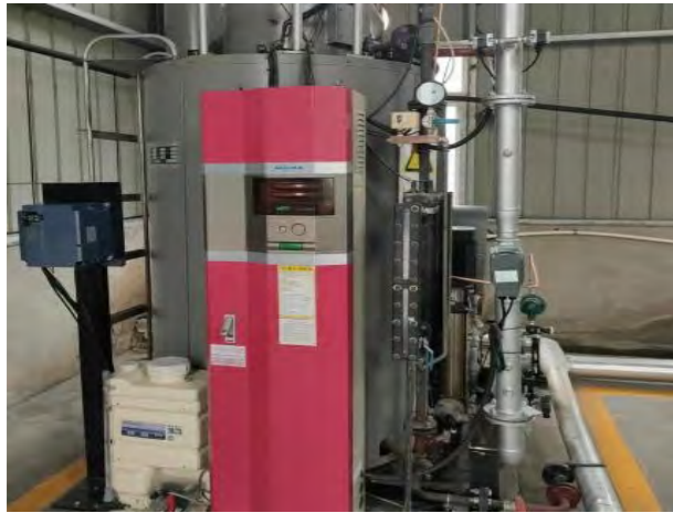
燃气锅炉改造
