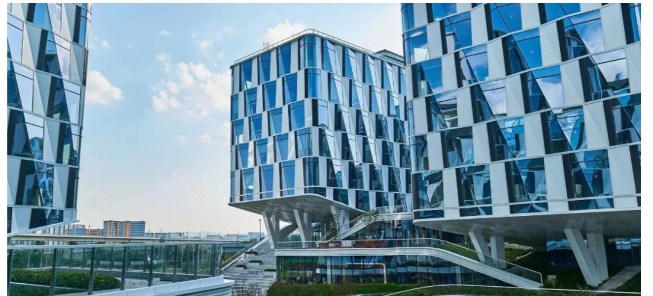
◎杭州个推总部大楼幕墙工程
