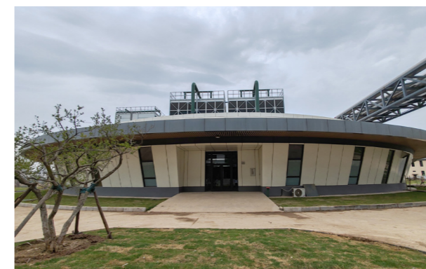
智能园区酿酒冷却循环水处理站
