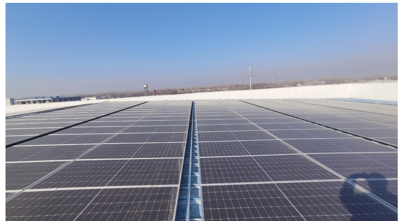
龙瑞玻璃在厂区屋面铺设分布式光伏电站
