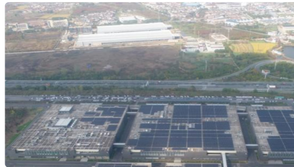
河阳光伏项目装机容量 5.724MWp，2023 年发电量 760.5 万千瓦时，超额完成年度目标发电量 588.4 万度
