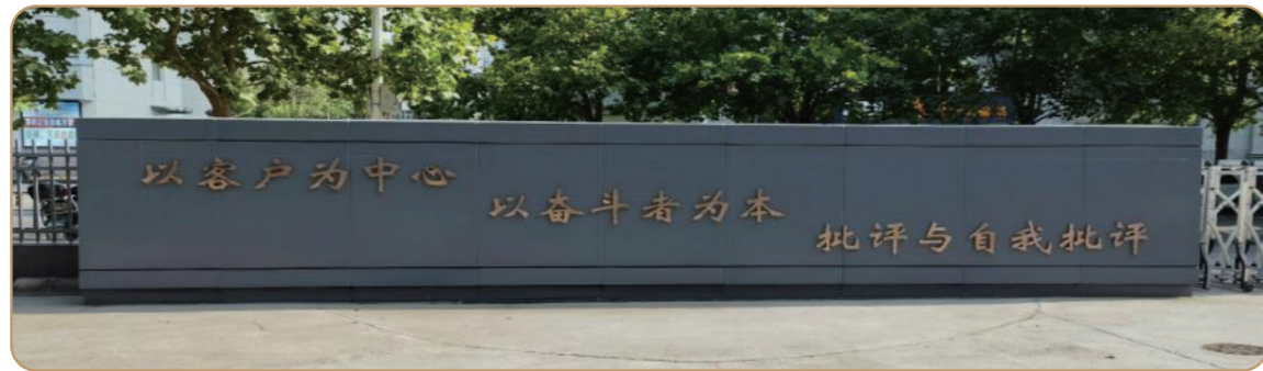
园区入口处石墙升级改造
