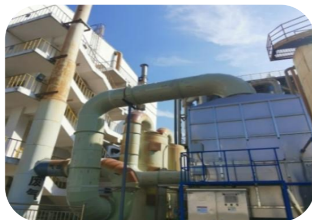
宿州公司进行废气处理装置升级改造，实施全流程异味治理，有效降低异味和废气排放
