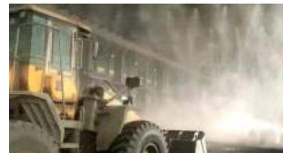
中金铜业公司原料仓喷雾抑尘装置
