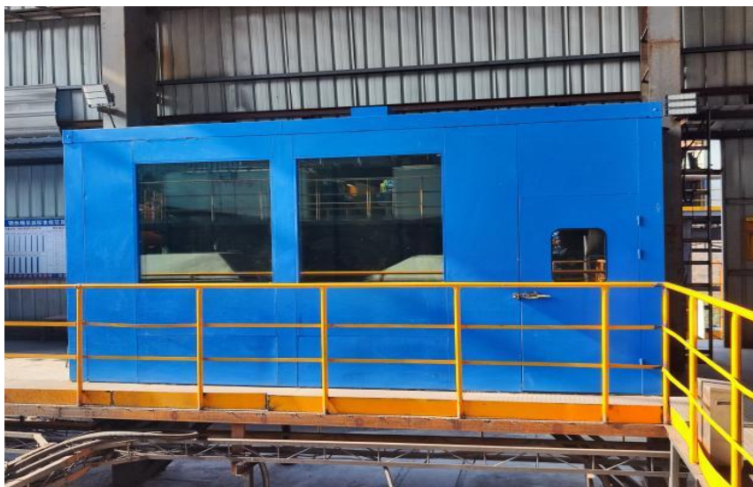
丰源矿业公司修建隔音室
