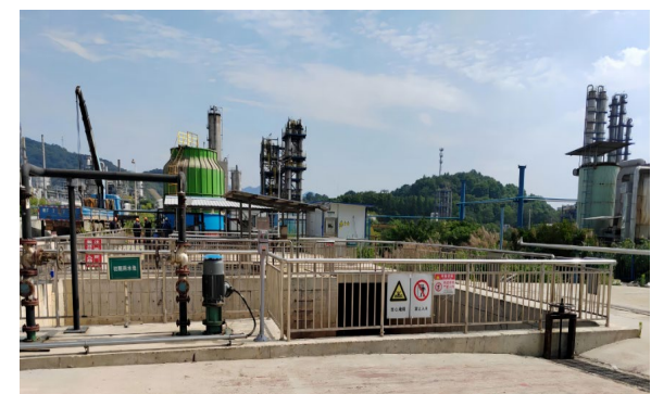
新岭化工雨水收集池
