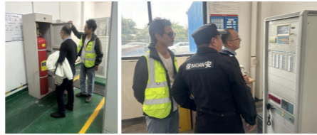
安全隐患排查
