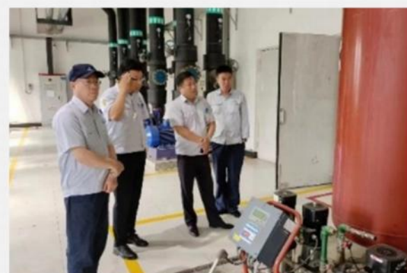
▲ 中国航发长春控制隐患巡检
