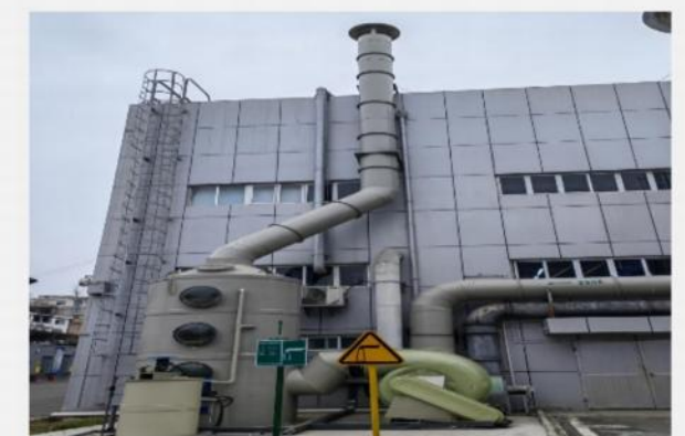
▲ 中国航发红林完成116厂房废气净化装置改造项目
