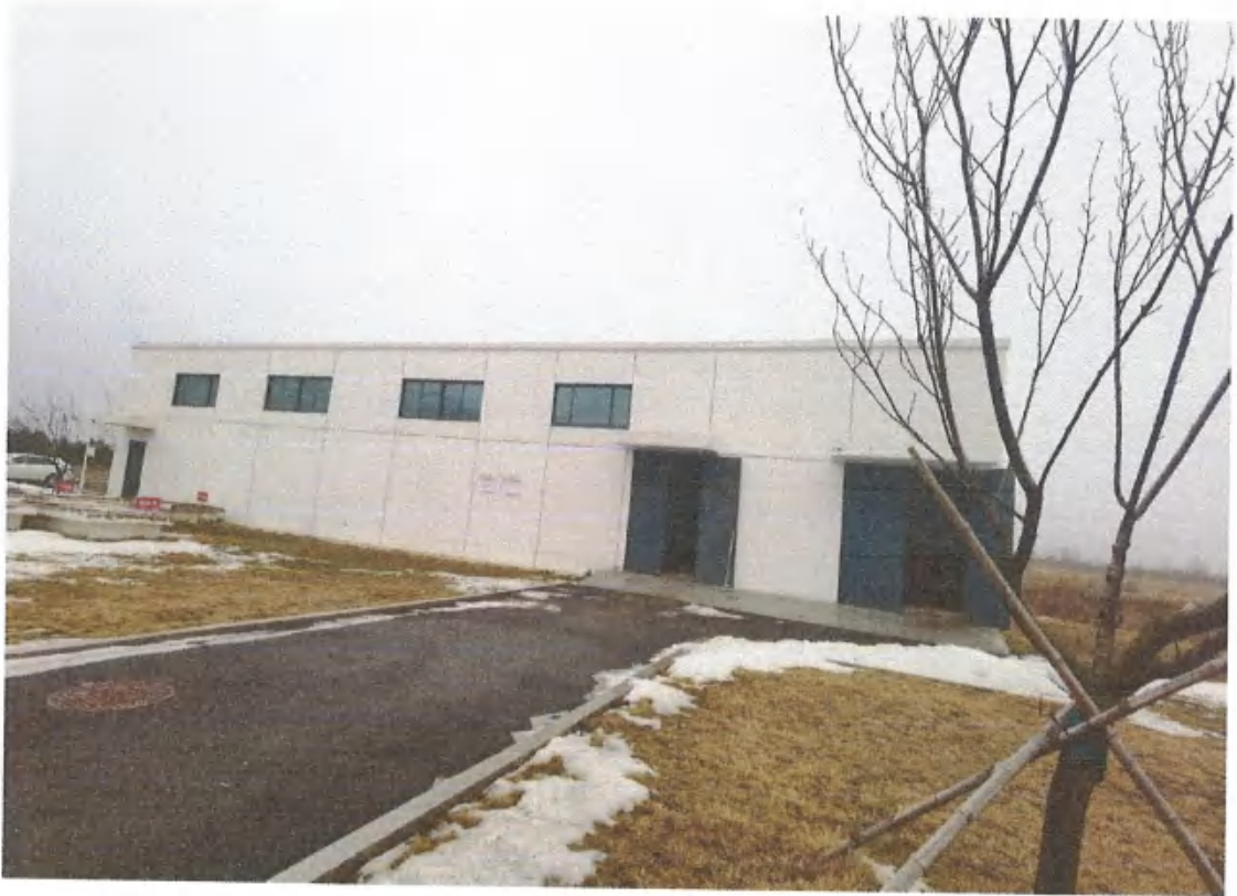
惠河路-90-19号污水处理站
