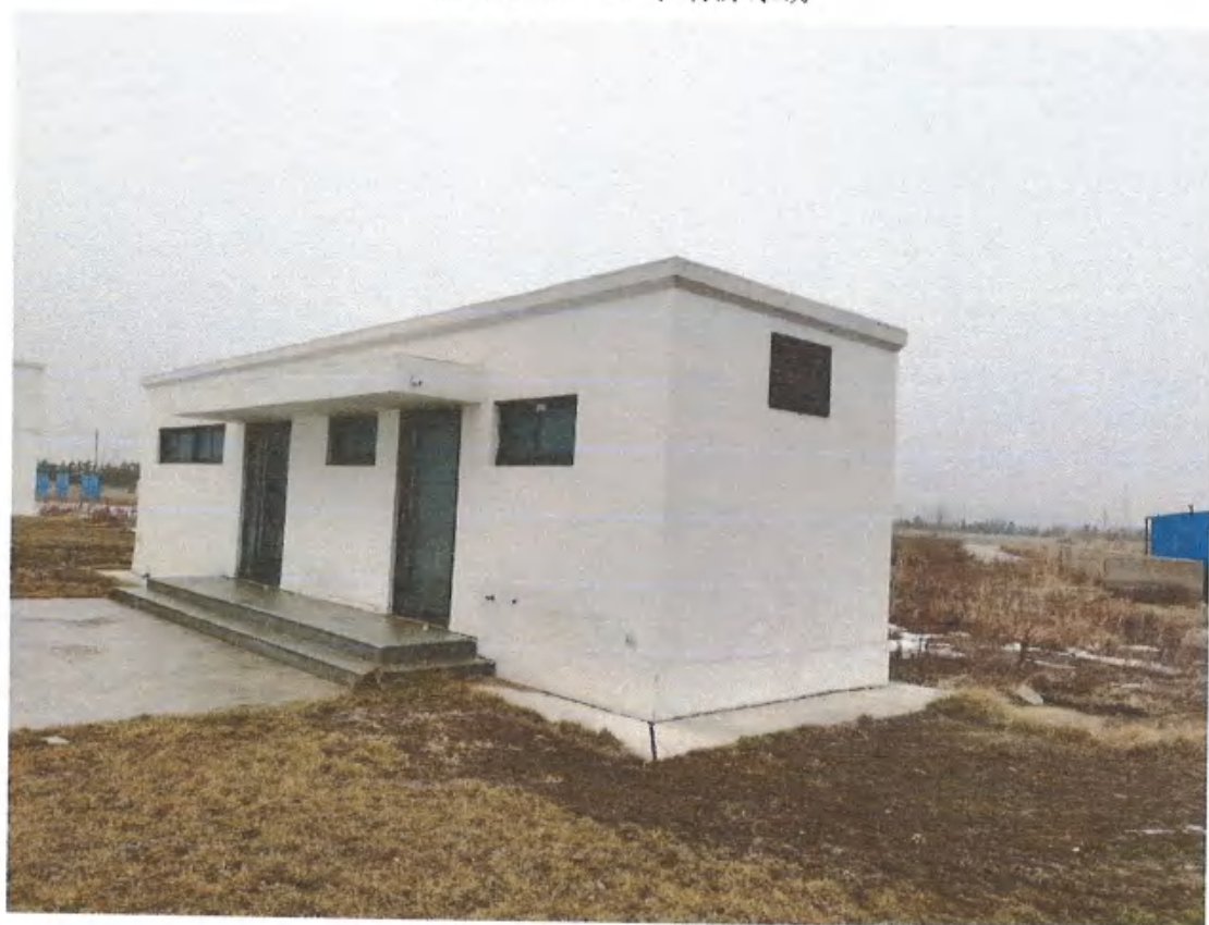
惠河路-90-18号消防泵房
