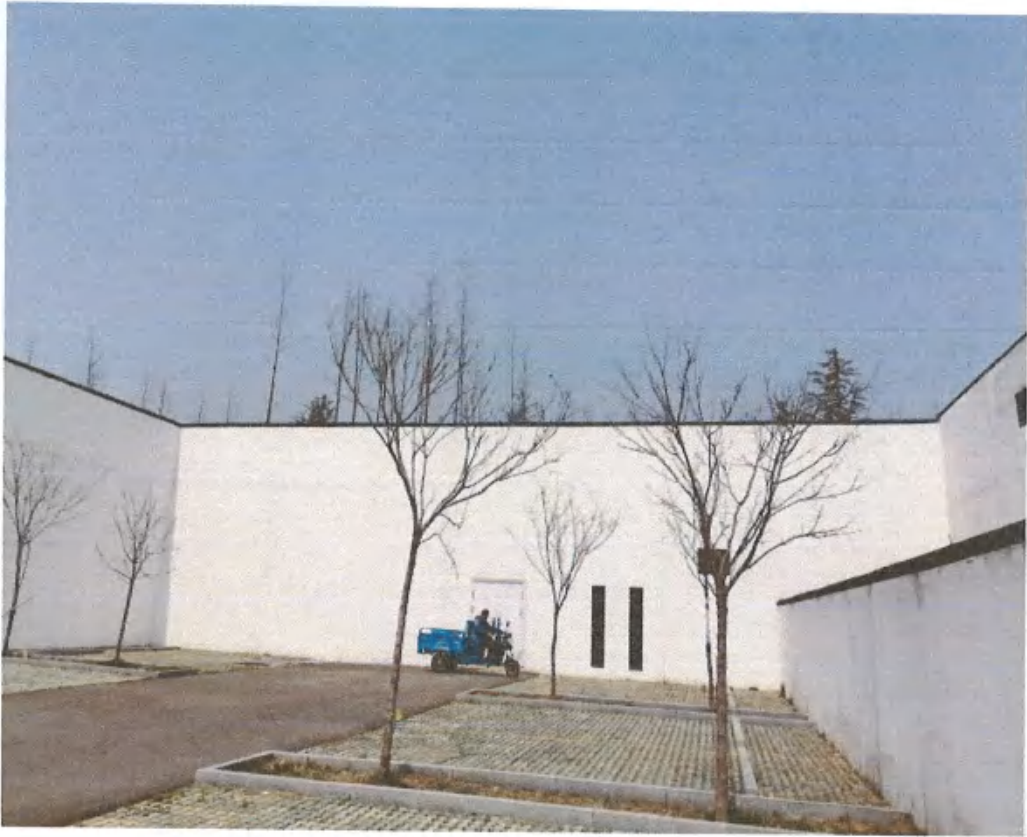
惠河路-90-29号水泵房
