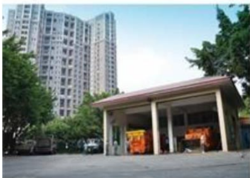
垃圾压缩中转站全貌
