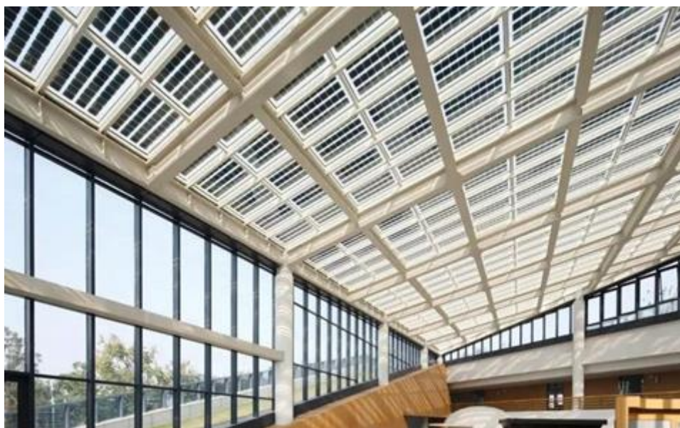
BIPV 图例：杭州西溪湿地龙舌嘴游客服务中心
